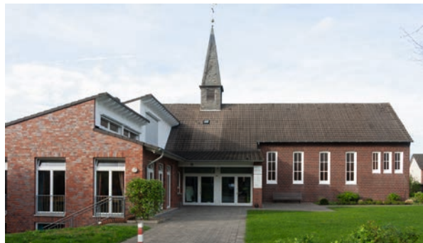
Das Gebäudeensemble der Evangelischen Christuskirche Olfen soll zukunftstauglich gemacht werden: in Zukunft eine multifunktionale Begegnungsstätte. Foto: Dr. Wolfgang Strickling/Benutzer: Creosoph, https://commons.wikimedia.org/wiki/File:Ev_Christus-Kirche_2024-04-05_Olfen-9102.jpg , Lizenz: CCo 1.0 Universell Deed
