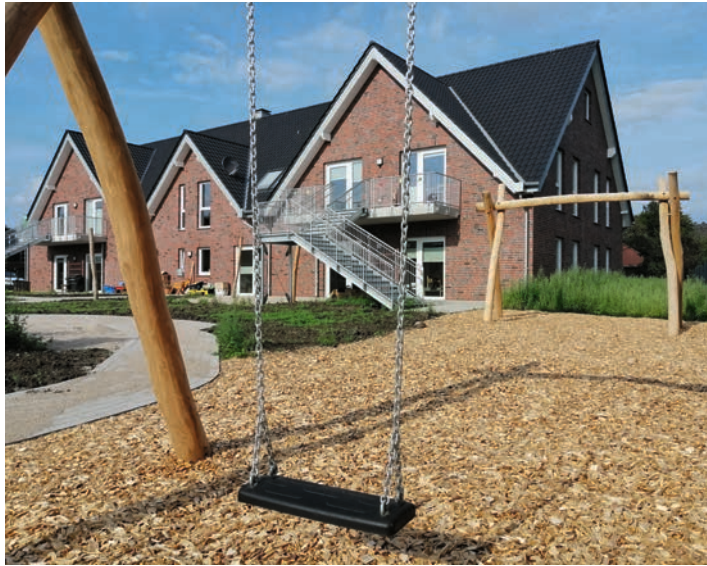
... und so es im August 2021 nach der Eröffnung aus: ein gelungenes Bauwerk. Foto: Thomas Dudzik.
